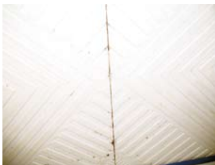
Rys. 5. Widoczne wyraźne zagrzybienia pod sufitem w narożu pokoju sypialnego.
