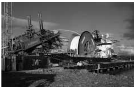
Rys. 2. Bęben umieszczony na statku, na który nawijany jest zespawany rurociąg (opracowanie własne)
